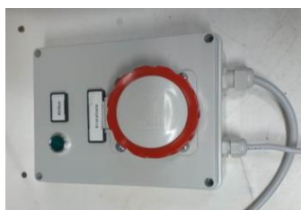
Esempio di attuatore (irroratore) comandato da uscita digitale Inverter
